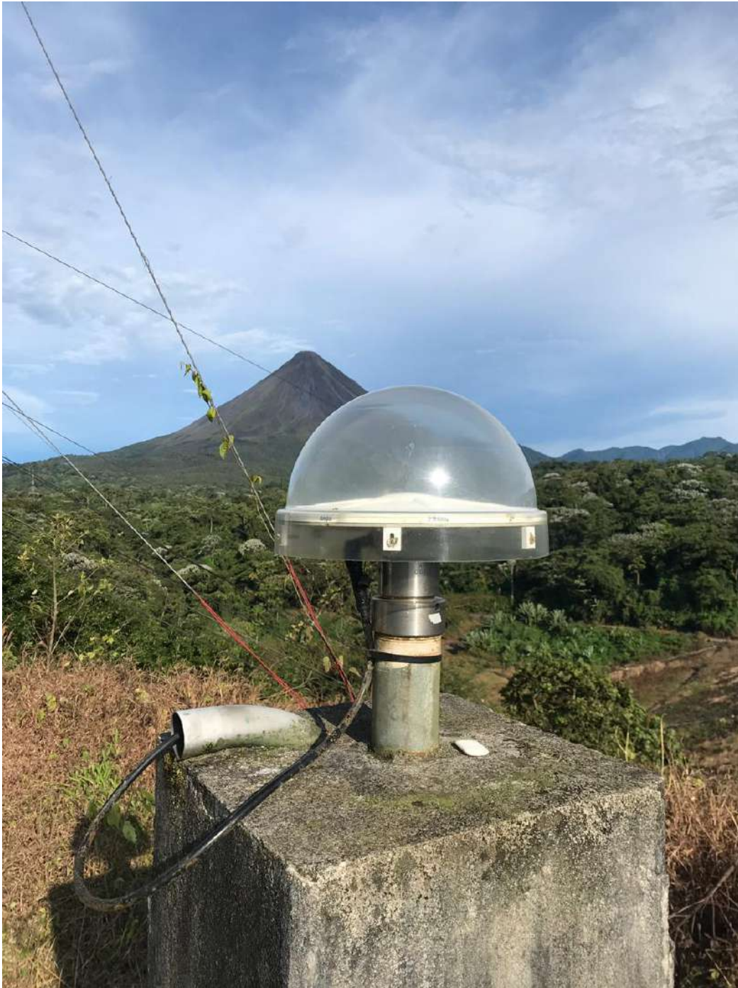
En esta fotografía del 16 de octubre del 2019 se observa un equipo GNSS del Área de Topografía del ICE ubicado en el flanco suroeste del volcán Arenal. Fotografía por José Ana González.
