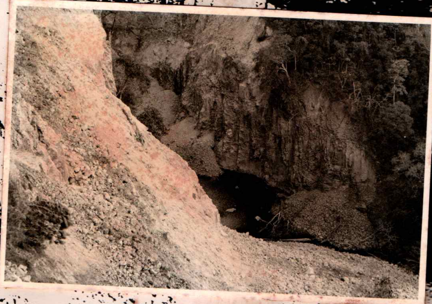
FOTO 22: Represamiento en el cauce del río Virilla a consecuencia de los deslizamientos producidos por la sacudida del sismo del 22 de diciembre de 1990.
