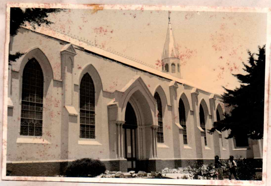
FOTO 3: Daños en la corniza sur de la Iglesia de Moravia, San José. Sismo del 25 de marzo de 1990.
