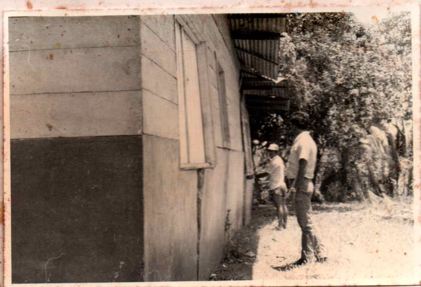
FOTO 8: Daños en construcciones de mala calidad, Cóbano. Temblor del 25 de marzo de 1990.
