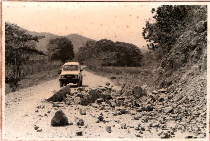
FOTO 9: Deslizamientos provocados por el sismo del 25 de marzo de 1990 en el camino de Paquera a Tambor.
