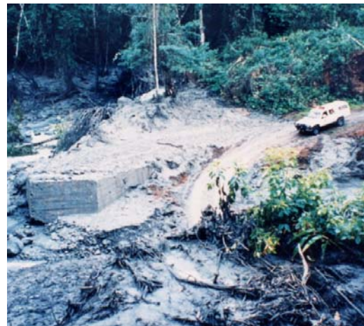
Foto 2: Lahares en el río Azul, con el puente arrasado, del 8 de mayo de 1991 (Foto de archivos del ICE).
