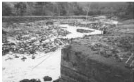
Fig. 10: Lahares en el río Pénjamo, con el puente arrasado, el 8 de mayo de 1991 (Foto de archivos del ICE).
